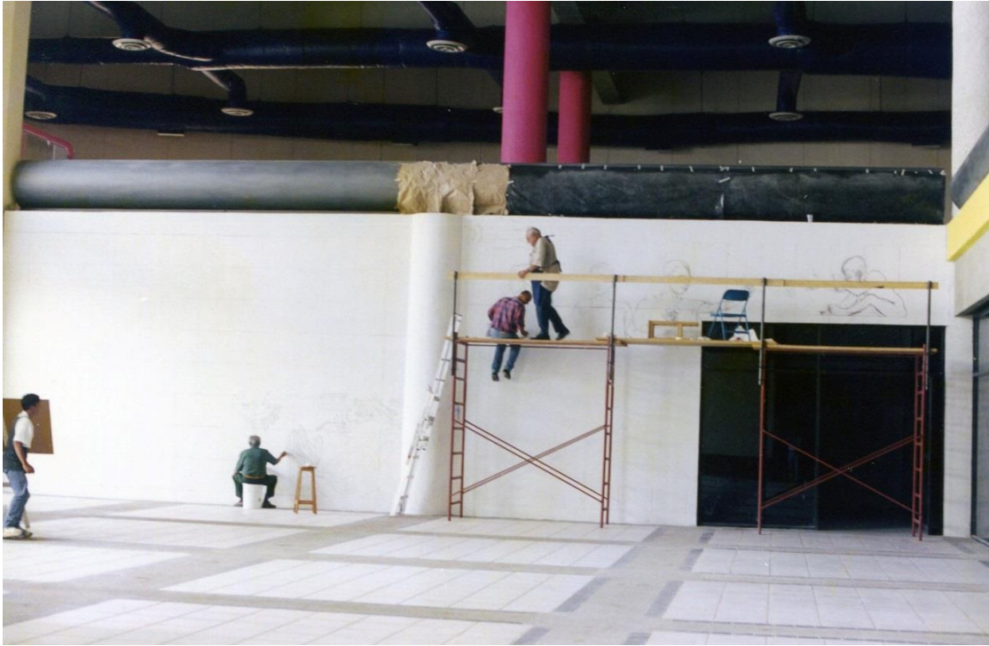
ELECCIÓN DEL MURO Y PREPARACIÓN DEL MISMO (MURO INTERIOR)
